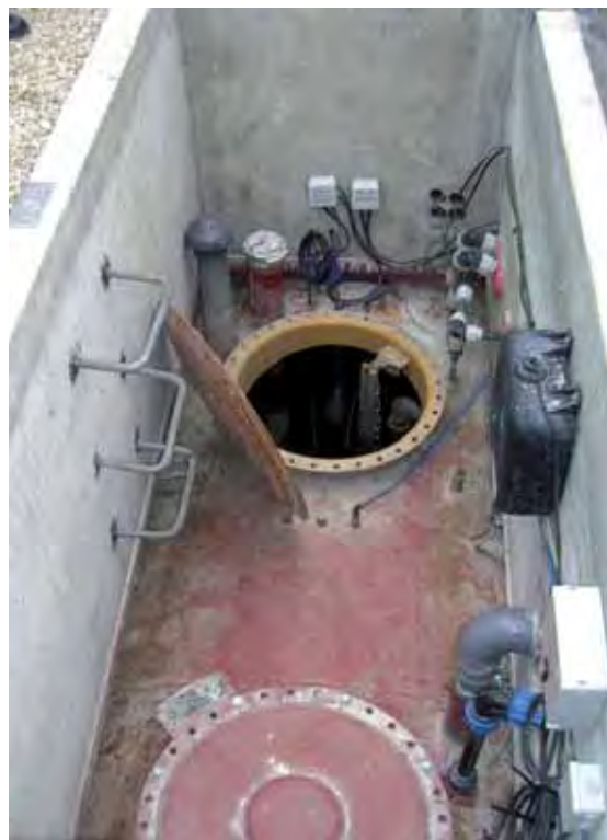
Aire de lavage d'Avize en Champagne avec sa cuve de récupération des effluents enterrée
