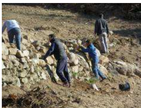
La construction des murets
